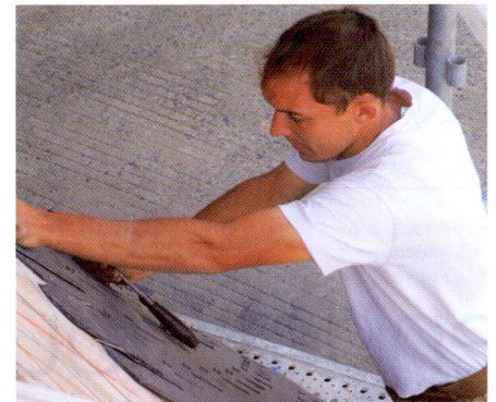
Manceau en train de poser de l'ardoise.
